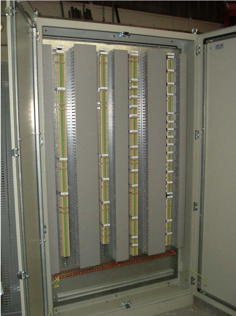
**L' armadio di confine per il telecontrollo è realizzato su misura, è conforme alle specifiche ENEL LV 509 - DY 911/11 ed e' munito di golfari per il sollevamento. Viti e bulloneria sono in acciaio inossidabile secondo le direttive UNI 3740 parte 7a. La sbarra di terra rispetta le caratteristiche previste nelle norme CEI 7-4.**
